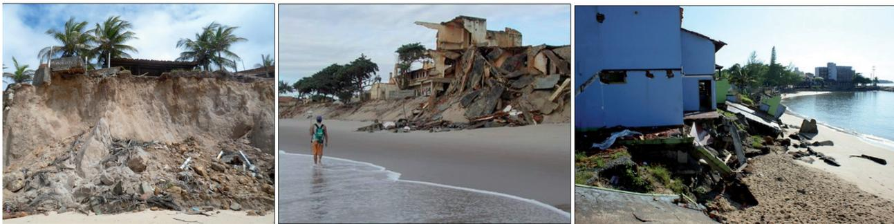
Figura 20. Calçadão da praia da Tartaruga, em Rio das Ostras (2009), destruído pela erosão marinha.
