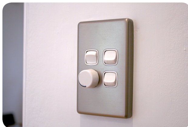
Figura 1: O dimmer é um equipamento que, uma vez instalado, possibilita a inserção controlada de uma resistência no circuito e, conseqüentemente, o controle da corrente que passa pela lâmpada.
