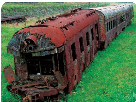
Figura 12: A ferrugem é resultado da oxidação do ferro que tem como um dos seus produtos o óxido de ferro, é ele o responsável pela cor avermelhada.
