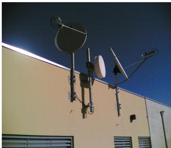
**Figura 18:** Antenas utilizadas para acesso, via satélite, à internet e serviço telefônico.
